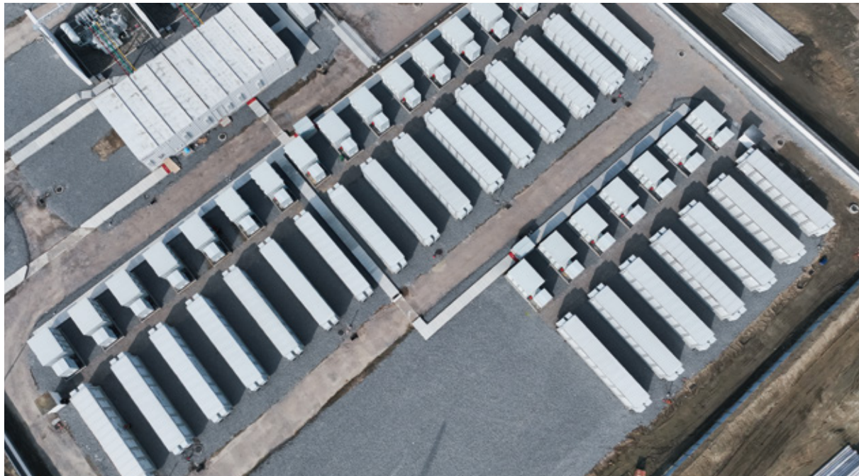
湖北仙桃200MW渔光互补发电57.5MW/115MWh储能项目
