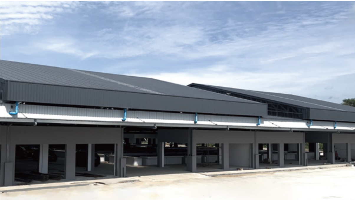
缅甸曼德勒农贸市场工商业储能项目
