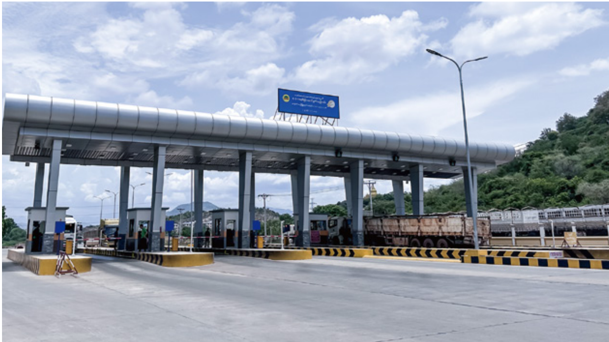
缅甸曼德勒SKG收费站工商业储能项目
