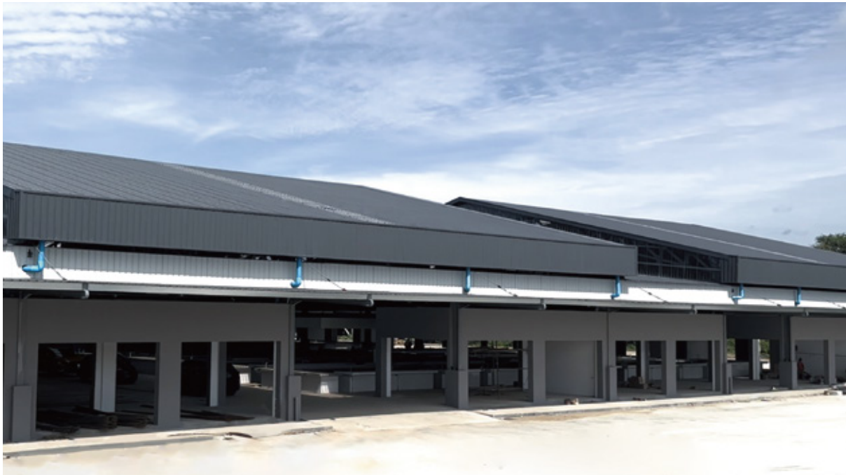
缅甸曼德勒农贸市场工商业储能项目
