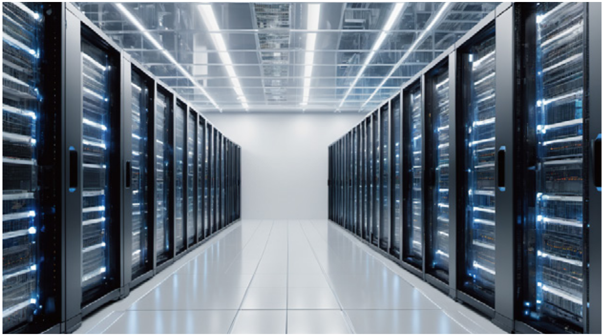
中国联通山西数据中心项目
