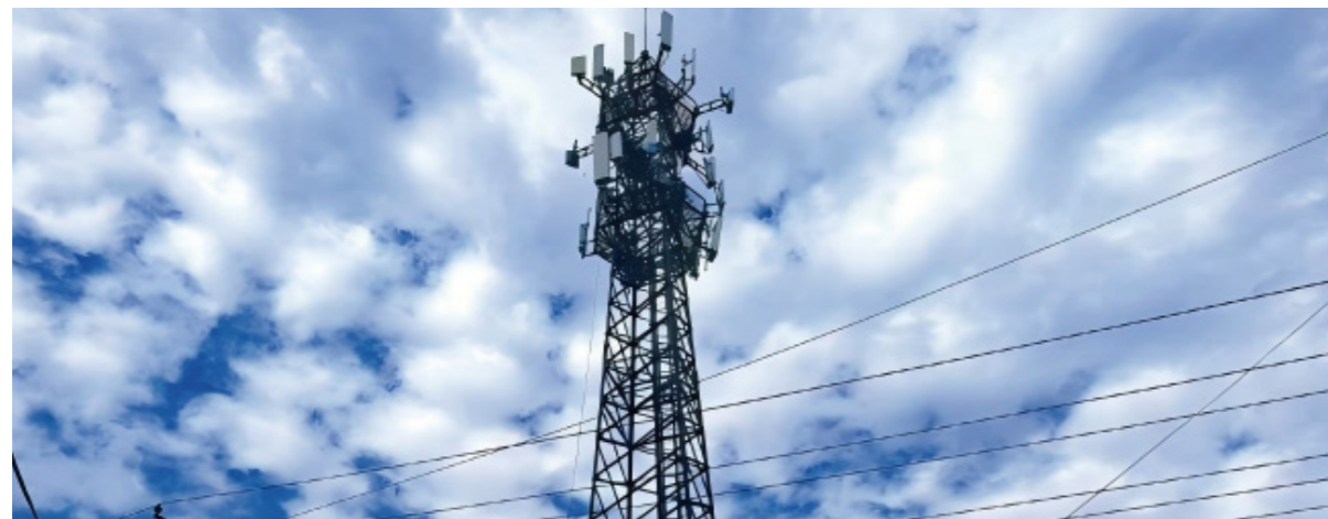
中国移动黑龙江智慧钠电项目 China Mobile Heilongjiang Smart Sodium Battery Project
