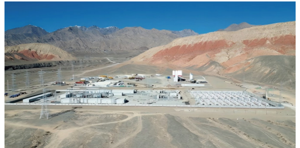
新疆乌恰50MW风能发电50MW/200MWh储能项目 项目时间: 2023年 项目地点: 新疆乌恰 项目特色: 戈壁大型风场, 长运行寿命
