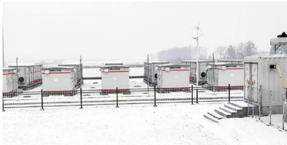
黑龙江伊春铁力年丰20MW风力发电20MW/40MWh电储能项目 项目时间: 2024年 项目地点: 黑龙江伊春 项目特色: 风电配储、电网支撑
