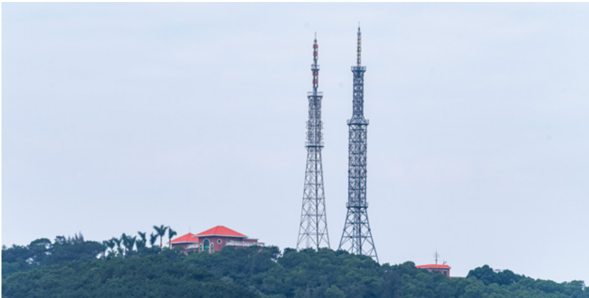
柬埔寨Metpone基站项目 项目时间: 2022年 项目地点: 柬埔寨
