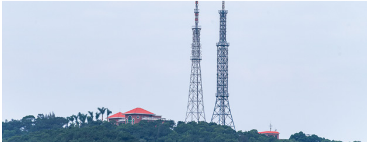
柬埔寨Metpone基站项目 Cambodia Metfone Base Station Project
