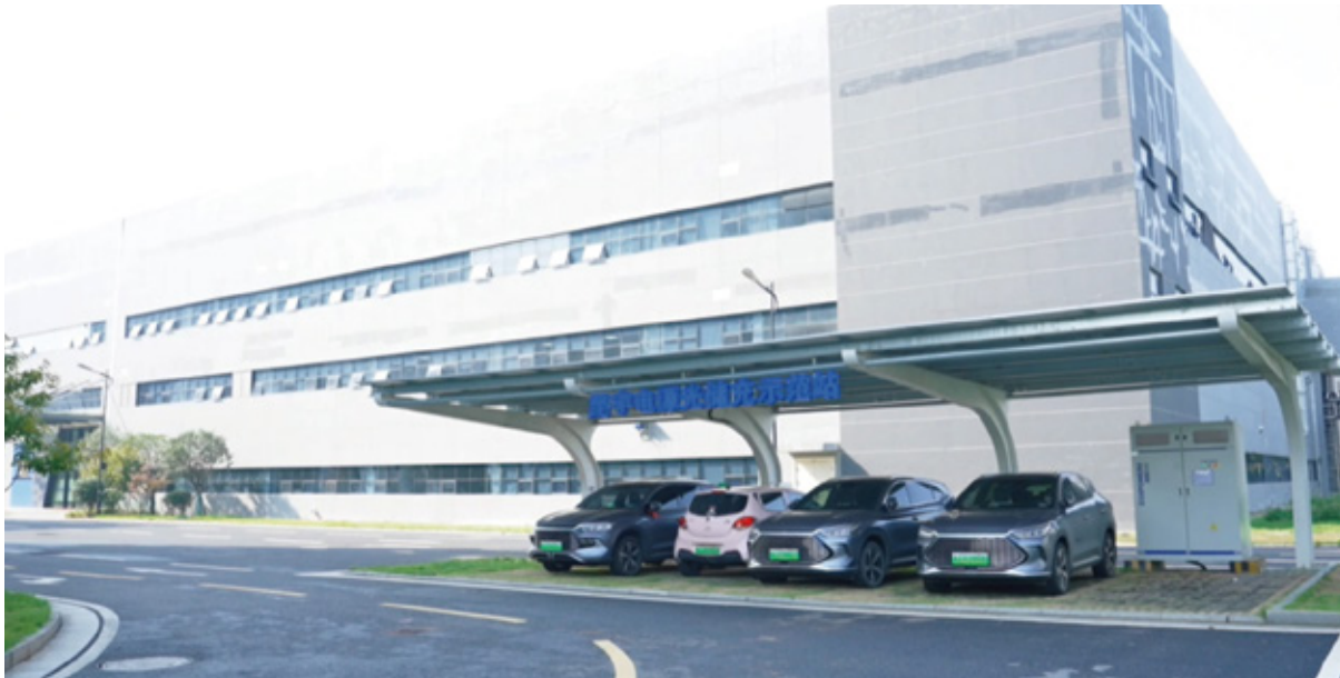
湖南常德光储充一体化充电站工商业储能项目 项目时间: 2023年 项目地点: 湖南
