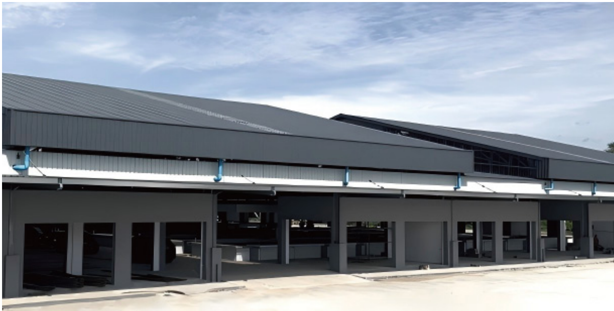
缅甸曼德勒农贸市场工商业储能项目 项目时间: 2023年 项目地点: 缅甸
